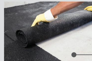
A manta deve ser apoiada sobre a laje limpa e isenta de impurezas. Para espessuras de até 5mm, sobrepor 5cm para evitar espaçamento. Para espessuras maiores, apoiar uma ao lado da outra e passar uma fita adesiva nas juntas. Aplicar uma lona plástica para impedir a passagem da massa nos poros do material.
