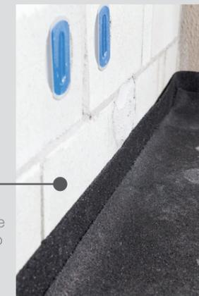
O rodapé acústico deve passar em todo perímetro do comodo evitando pontes de contato com a estrutura. É recomendado que o reboco seja executado antes da instalação das mantas para que ele não tenha contato com o sistema de piso.
